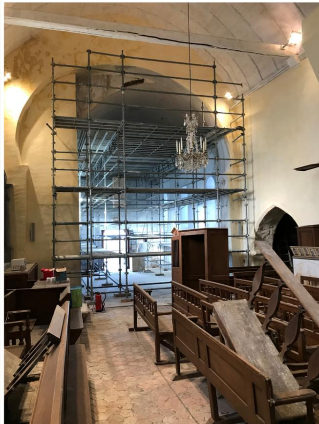
SNBR a eu en charge la mise en place de l'ensemble des échafaudages, tant extérieurs qu'intérieurs, et l'installation d'une bâche étanche fermant totalement la nef du chœur où l'ensemble du mobilier a été stocké dans l'attente des travaux de restauration.
