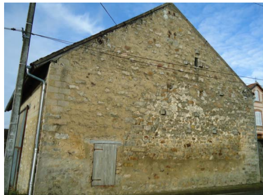
Grange située entre le 20 et le 24 rue de la Grande rue (parcelle 70)
